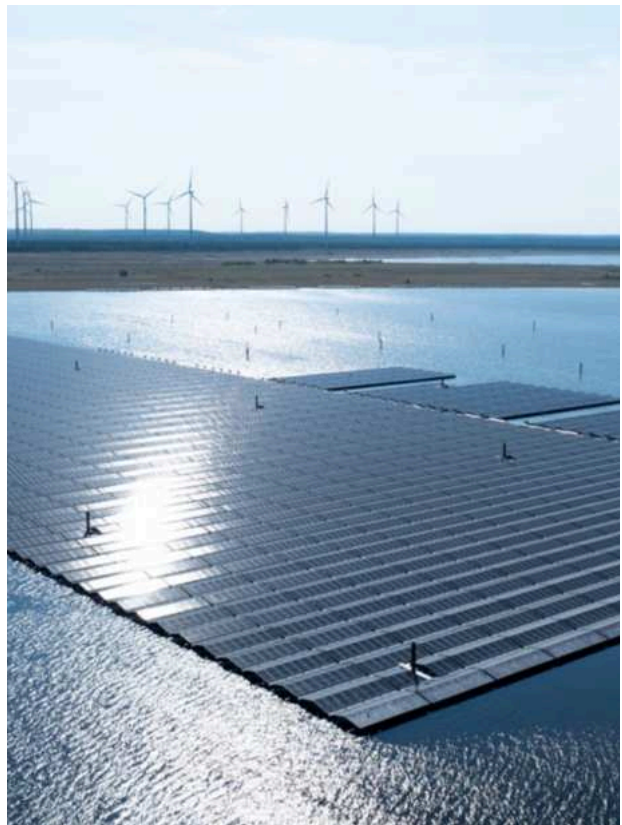
Abb. 71: Schwimmende Solaranlagen auf Tagebaufolgesee (Quelle: pv-magazine.de)
